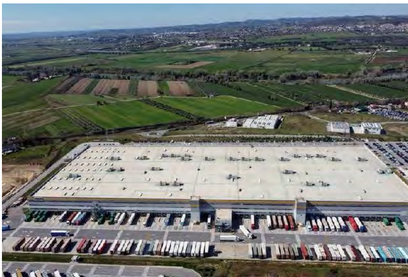
Un centro della logistica, certamente utile, ma che ha sottratto c. 8 ettari di terreno agricolo (che, se coltivato a grano, avrebbe reso annualmente 5-7 t), impermeabilizzando un suolo in un'area dal pendio molto modesto, con pochi rischi di erosione. Secondo ISPRA ogni giorno si cementificano circa 19 ettari di terreno. (da Nuova Ecologia, 21.1.2023)
